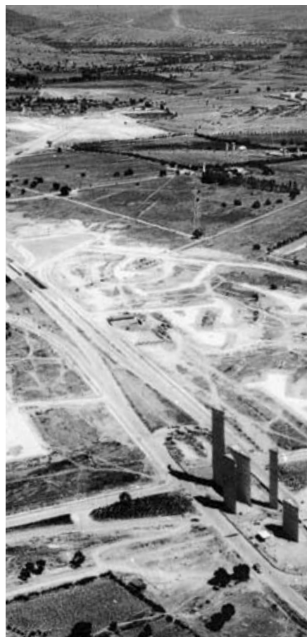
Vista aérea de las torres al momento de su construcción en 1957.
